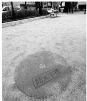
御蔵南公園のグラウンドに排水溝を4ヶ所設置。上に簡易トイレを置き、水を流せば下水道へ処理できる(右)。また、震災時に水が使えなかったことを教訓に、グラウンドの下には100 tの水槽を埋め込んでいる(上)
